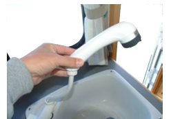
伸縮式シャワーヘッドは窓ガラスから外に出し専用フックに引っ掛けることで 外部シャワーとしても使えます。
